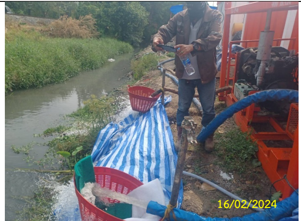
ง) ตะแกรงดักตะกอนก่อนระบายน้ำทิ้ง
