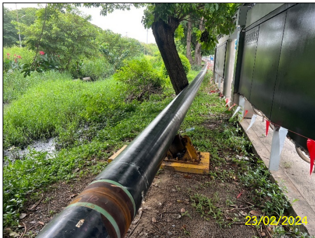
ข) การจัดวางท่อขนส่งน้ำมันบนวัสดุรองรับ
