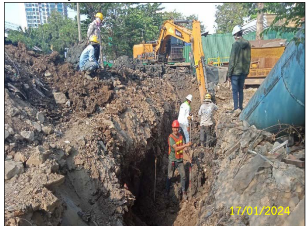
ตรวจสอบแนวท่อและระบบสาธารณูปโภคเดิม
