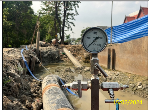
ค) ปรับแรงดันน้ำจากการทดสอบท่อโดยวิธีทางชลสถิต
