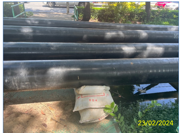
ข) การจัดวางท่อขนส่งน้ำมันบนวัสดุรองรับ
