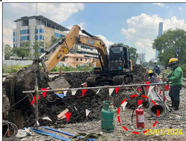
ช) จัดเตรียมอุปกรณ์ดับเพลิงในบริเวณที่อาจก่อให้เกิดประกายไฟในพื้นที่ก่อสร้าง รูปที่ 2-26 (ต่อ) กิจกรรมการดำเนินงานด้านความปลอดภัยในการทำงาน
