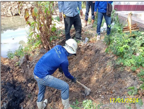
ตรวจสอบแนวท่อและระบบสาธารณูปโภคเดิม
