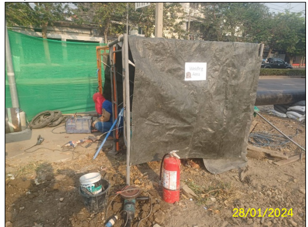
ค) การกั้นเขตบริเวณที่มีการเชื่อม และติดตั้งป้ายเตือนห้ามผู้ที่ไม่เกี่ยวข้องเข้ามาในพื้นที่ปฏิบัติงาน
