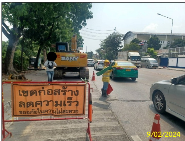
ก) ป้ายเตือน เครื่องหมายจราจร ไฟสัญญาณจราจรต่างๆ บริเวณพื้นที่ก่อสร้าง รูปที่ 2-22 การติดตั้งเครื่องหมายจราจร ป้ายเตือน แผงกั้น กรวยพลาสติก ไฟกระพริบ และเจ้าหน้าที่อำนวยความสะดวกด้านการจราจร
