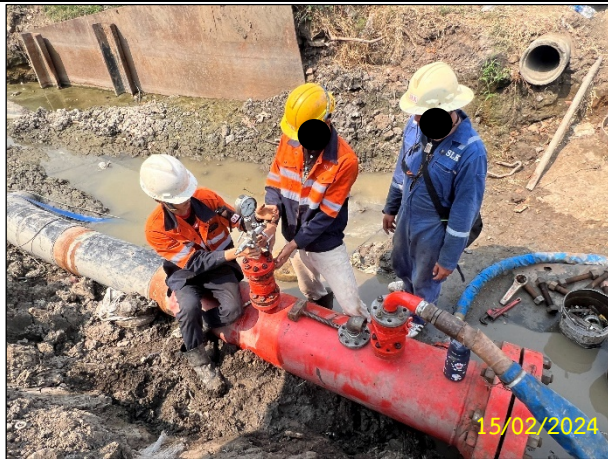
ค) ปรับแรงดันน้ำจากการทดสอบท่อโดยวิธีทางชลสถิต
