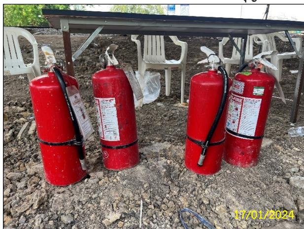
ช) จัดเตรียมอุปกรณ์ดับเพลิงในบริเวณที่อาจก่อให้เกิดประกายไฟในพื้นที่ก่อสร้าง รูปที่ 2-26 (ต่อ) กิจกรรมการดำเนินงานด้านความปลอดภัยในการทำงาน
