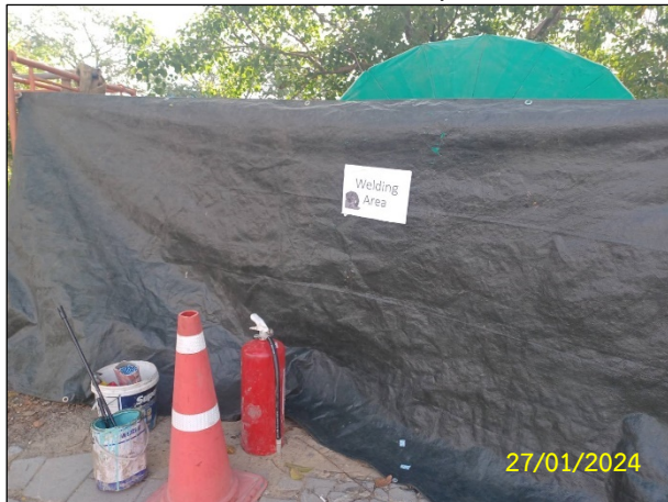
ค) การกั้นเขตบริเวณที่มีการเชื่อม และติดตั้งป้ายเตือนห้ามผู้ที่ไม่เกี่ยวข้องเข้ามาในพื้นที่ปฏิบัติงาน
