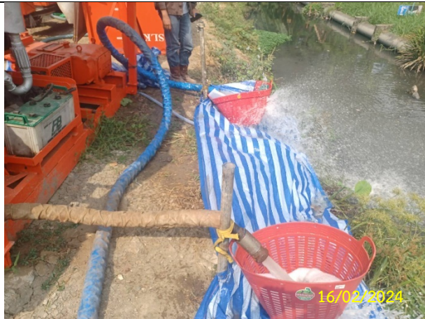
ง) ตะแกรงดักตะกอนก่อนระบายน้ำทิ้ง
