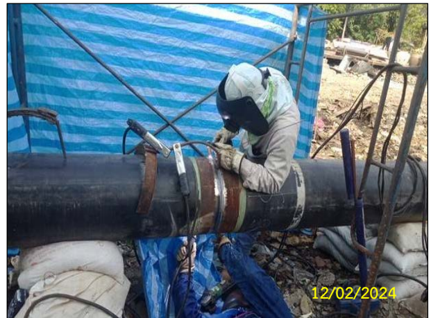
ข) การสวมใส่อุปกรณ์ป้องกันอันตรายส่วนบุคคล (PPE) สำหรับงานเชื่อมท่อ
